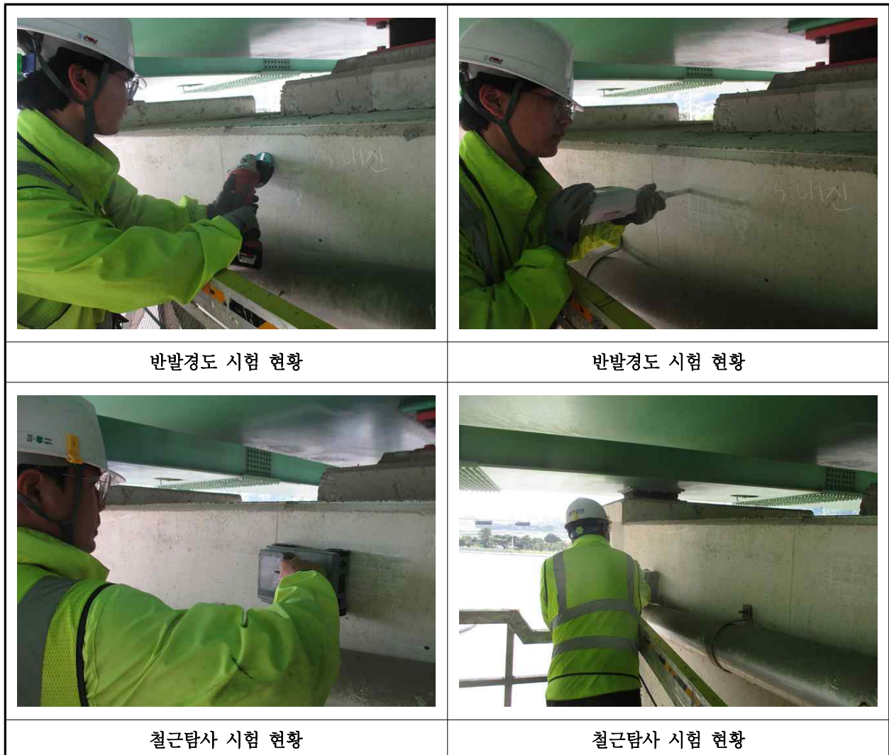
【사진 1.3.1】 콘크리트 내구성조사 현황
